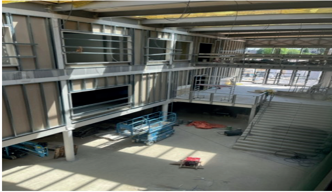
De leerlingeningang in aanbouw.
